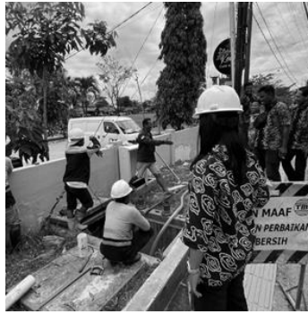
Gambar 1 Mengawasi Pekerjaan Perbaikan Pipa
