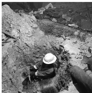
Gambar 4 Mengawasi Pembongkaran Pipa
