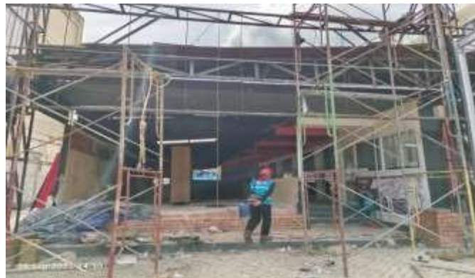
Gambar 1 Petugas K3 Sedang Mengamati Bangunan Dekat Jaringan Tegangan Menengah
