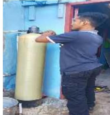
Gambar 4.4 pemasangan filter air
