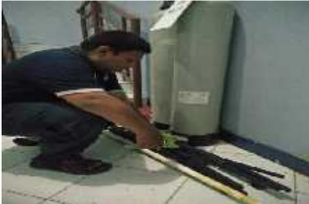
Gambar 4.2 Pemotongan pipa
